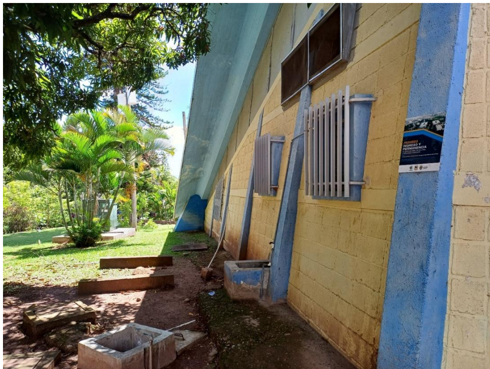
Fotografía lateral del Auditorio. Exterior de baños (Fotografía Mónica Reyes)
