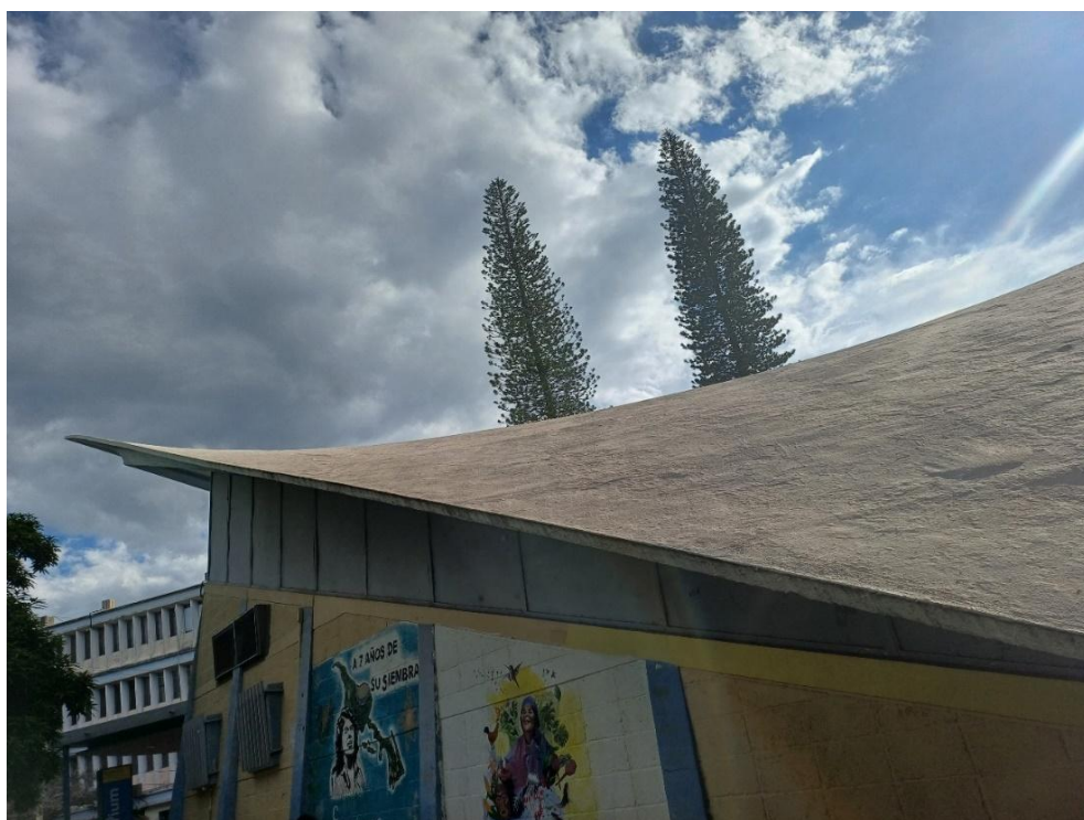
Fotografía de losa de techo (Fotografía Mónica Reyes)
