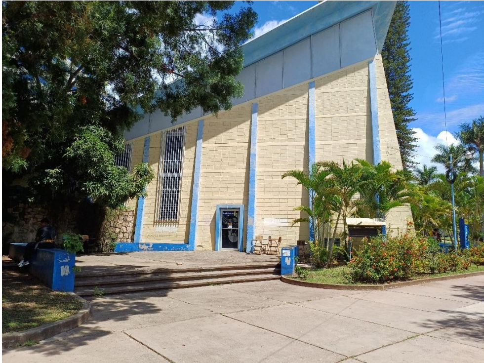
Fachada lateral de Auditorio Juan Lindo (Fotografía Mónica Reyes)
